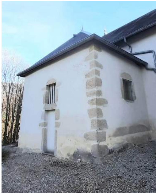
Toit de l'église
